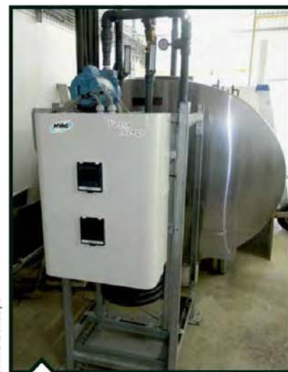
L'unité d'échange de chaleur à l'intérieur est assez compacte et possède des serpents contenant du glycol.
