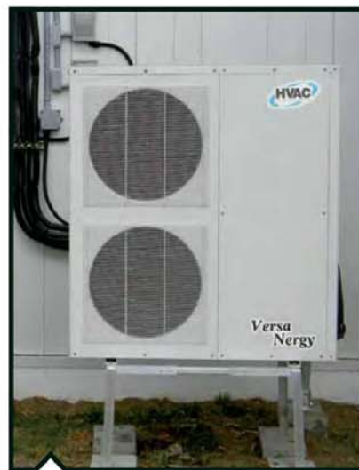
La thermopompe à la Ferme Rémy mise sur deux unités extérieures, dont l'une présentée sur cette photo. Ces unités peuvent fonctionner jusqu'à - 25 °C.
