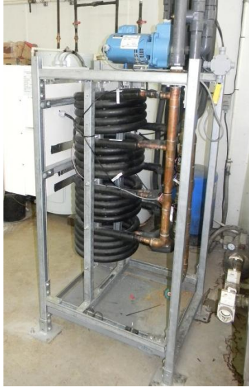
Figure 2. Échangeur de chaleur à double paroi ventilé - quatre sections
